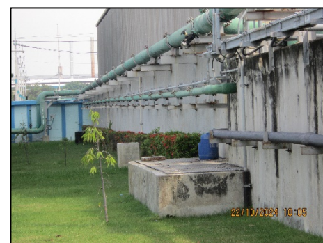
ภาพที่ 2.3-6 Septic Tank
