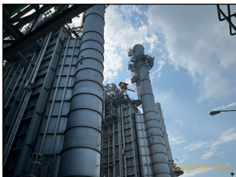
ภาพที่ 2.3-1 ปล่องระบายอากาศ HRSG 1 (11) และ HRSG 2 (12)
