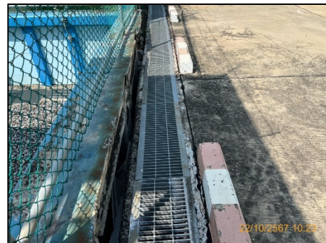
ภาพที่ 2.3-12 ระบบระบายน้ำฝนไม่ปนเปื้อน
