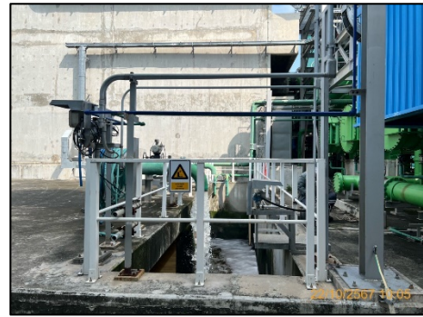
ภาพที่ 2.3-10 บ่อพักน้ำทิ้ง ขนาด 1,000 ลบ.ม.
