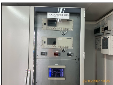
ภาพที่ 2.3-3 ระบบติดตามตรวจวัดมลพิษอากาศ จากอุตสาหกรรมอย่างต่อเนื่อง (CEMs)
