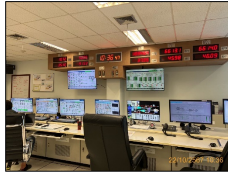
ภาพที่ 2.3-40 มาตรวัดระดับน้ำ และจอมอนิเตอร์
