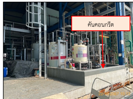
ภาพที่ 2.3-37 คั่นคอนกรีตล้าถึงสารเคมี
