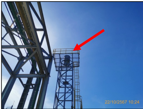
ภาพที่ 2.3-17 อุปกรณ์ลดเสียง (Silencer)
