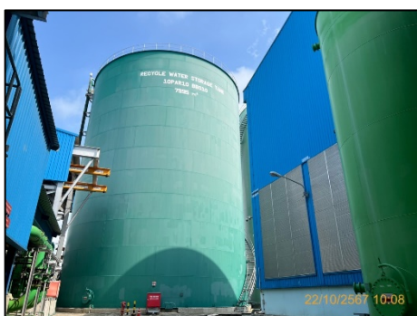
ภาพที่ 2.3-5 ถังเก็บน้ำหล่อเย็นสำรอง 6,000 ลบ.ม.
