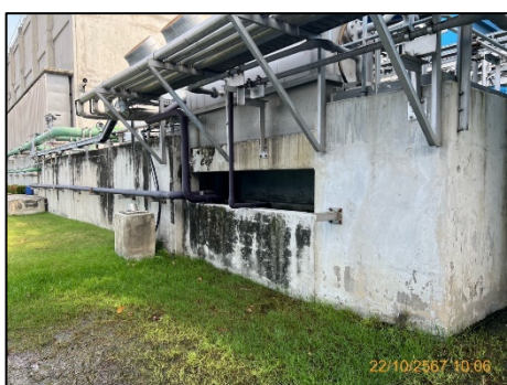
ภาพที่ 2.3-7 บ่อพักน้ำทิ้ง ขนาด 3 ลบ.ม.
