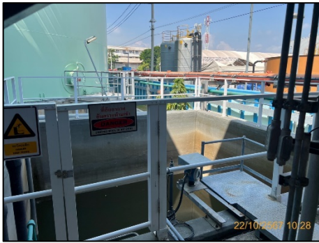
ภาพที่ 2.3-9 บ่อปรับสภาพน้ำเสียขนาด 80 ลบ.ม.
