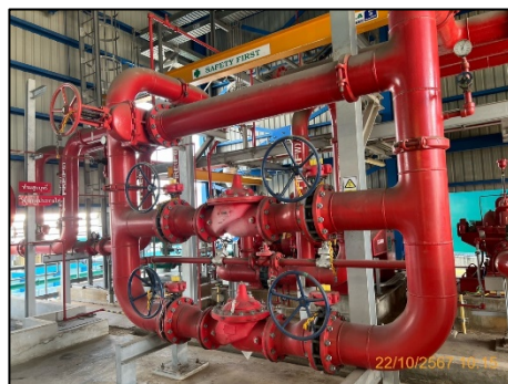
ภาพที่ 2.3-33 ระบบปั้มน้ำดับเพลิง
