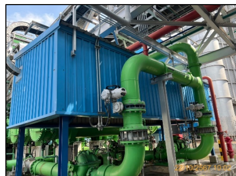
ภาพที่ 2.3-39 ปั๊มน้ำเติมหม้อไอน้ำสำรอง
