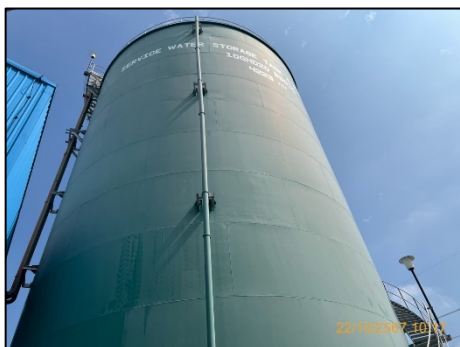
ภาพที่ 2.3-32 ถังน้ำสำรองเพื่อการดับเพลิง
