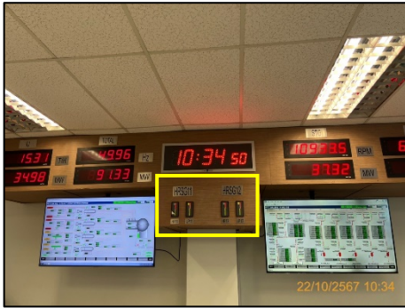
ภาพที่ 2.3-40 มาตรวัดระดับน้ำ และจอมอนิเตอร์
