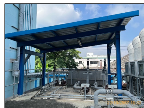
ภาพที่ 2.3-8 Oil Separator ขนาด 45 ลบ.ม.
